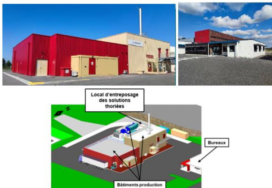
Figure 93 : Bâtiments de l'installation LMT
