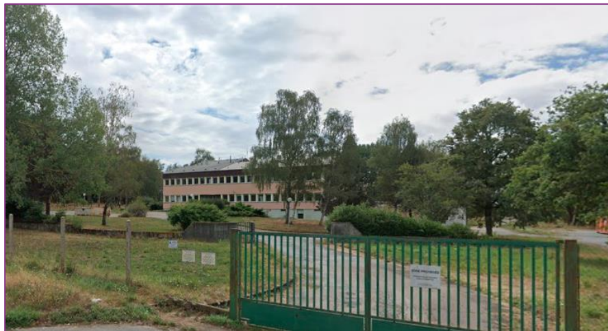
Figure 73 : Vue de l'installation SAN 2022
