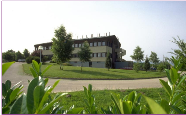
Figure 70 : Vue de l'installation SAN en 1997
