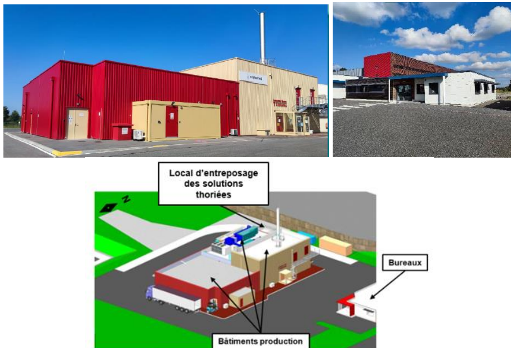
Figure 3 : Bâtiments du LMT (vue depuis le Sud-Est)
