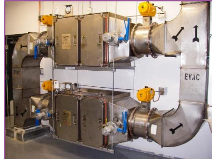
Figure 98 : Illustration d'une filtration avec filtre à Très Haute Efficacité (THE)
