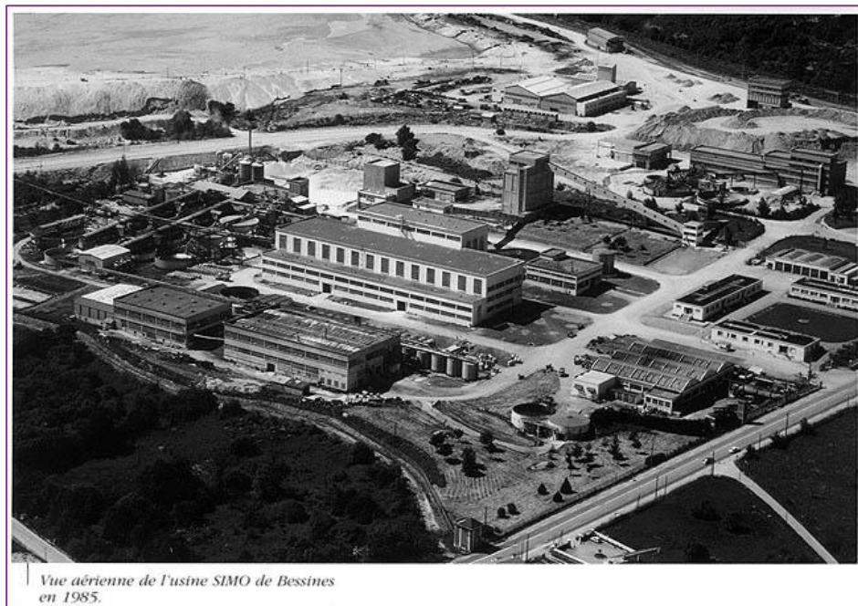
Figure 69 : Vue aérienne de l'usine SIMO 1985
